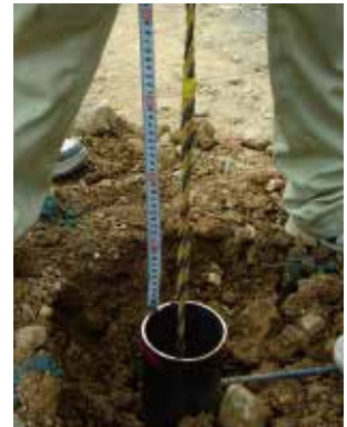
落下高さ確認
